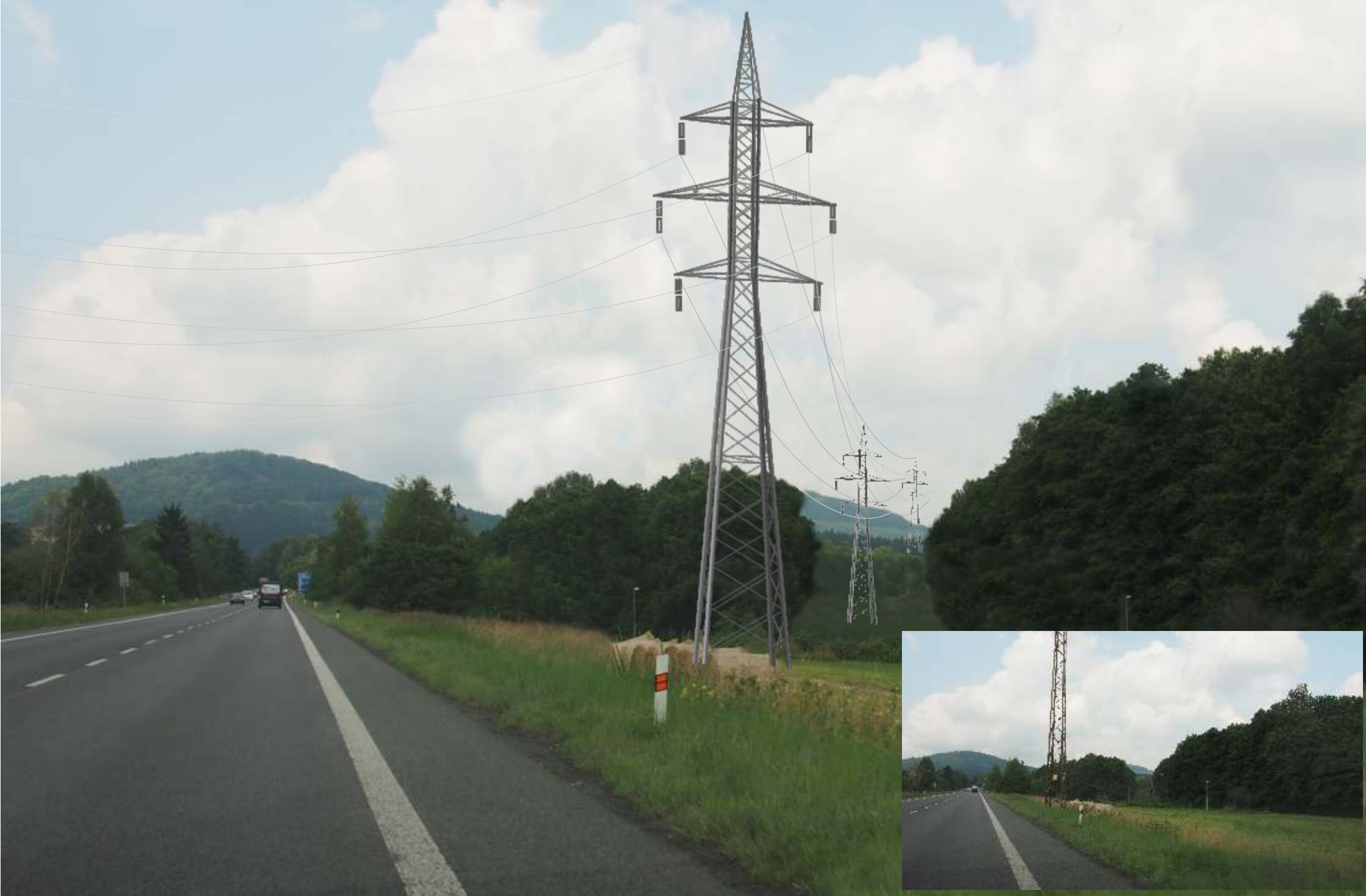
Pohled od Cvikova na Svor, využívány stožáry „Soudek” s dvojpotahem pro 110 kV a 35 kV v trase stávajícího vedení 35 kV
