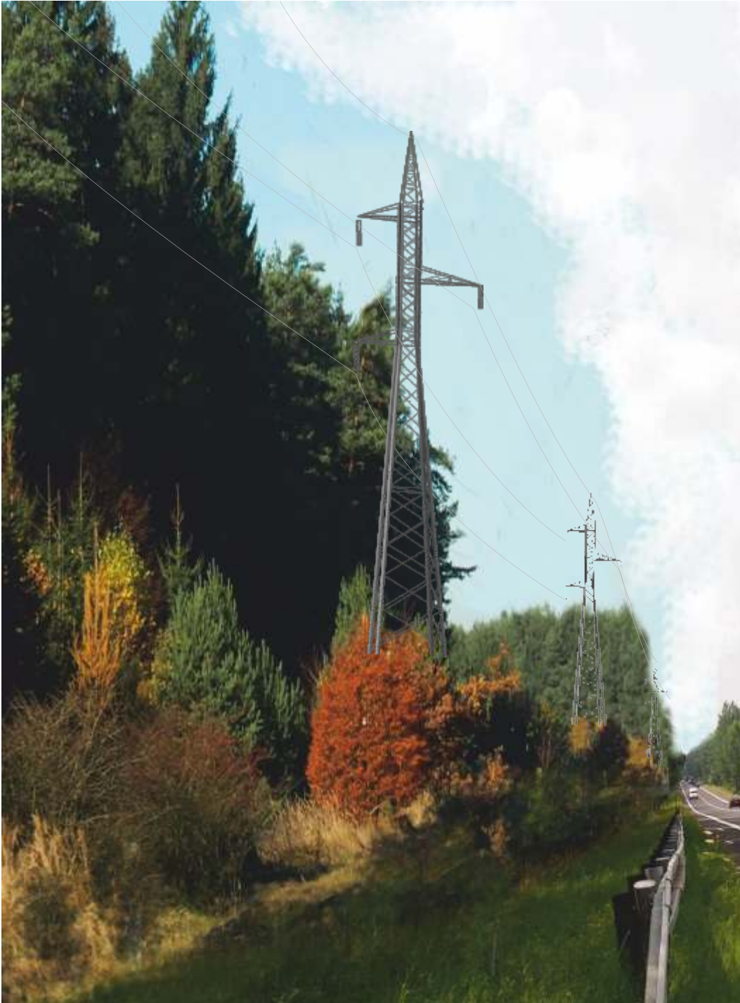
Jižní varianta vedení VVN 110 kV podél silnice I/9 Nový Bor - Svor. Minimalizuje se ochranné pásmo a odstup od silnice. Stožáry jsou částečně kryty pouze podrostem do výšky 3m
