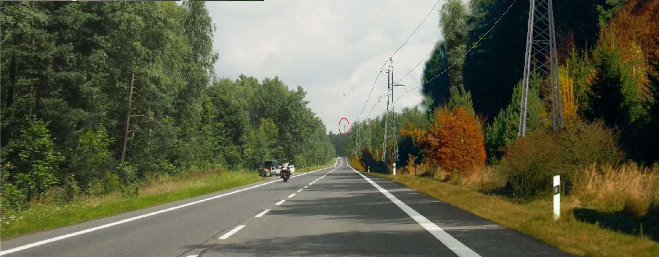
Jižní varianta vedení VVN 110 kV podél silnice I/9 Nový Bor - Svor. Minimalizuje se ochranné pásmo a odstup od silnice. Stožáry jsou částečně kryty pouze podrostem do výšky 3m
