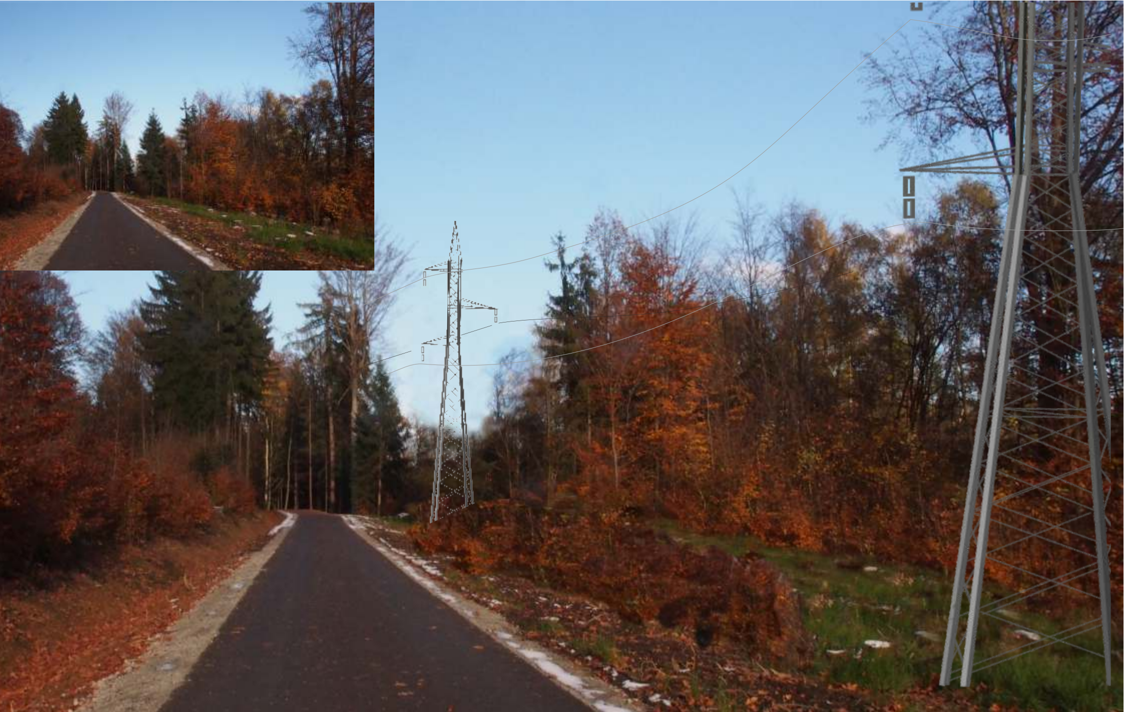
Vedení 110 kV souběžně s cyklostezkou Nový Bor - Svor. Stožáry jsou kryty nízkým podrostem (do 3m). Pohledově působí jako výrazná negativní dominanta. Příhradová konstrukce stožáru typu „Soudek” působí lehčeji díky své průhlednosti.
