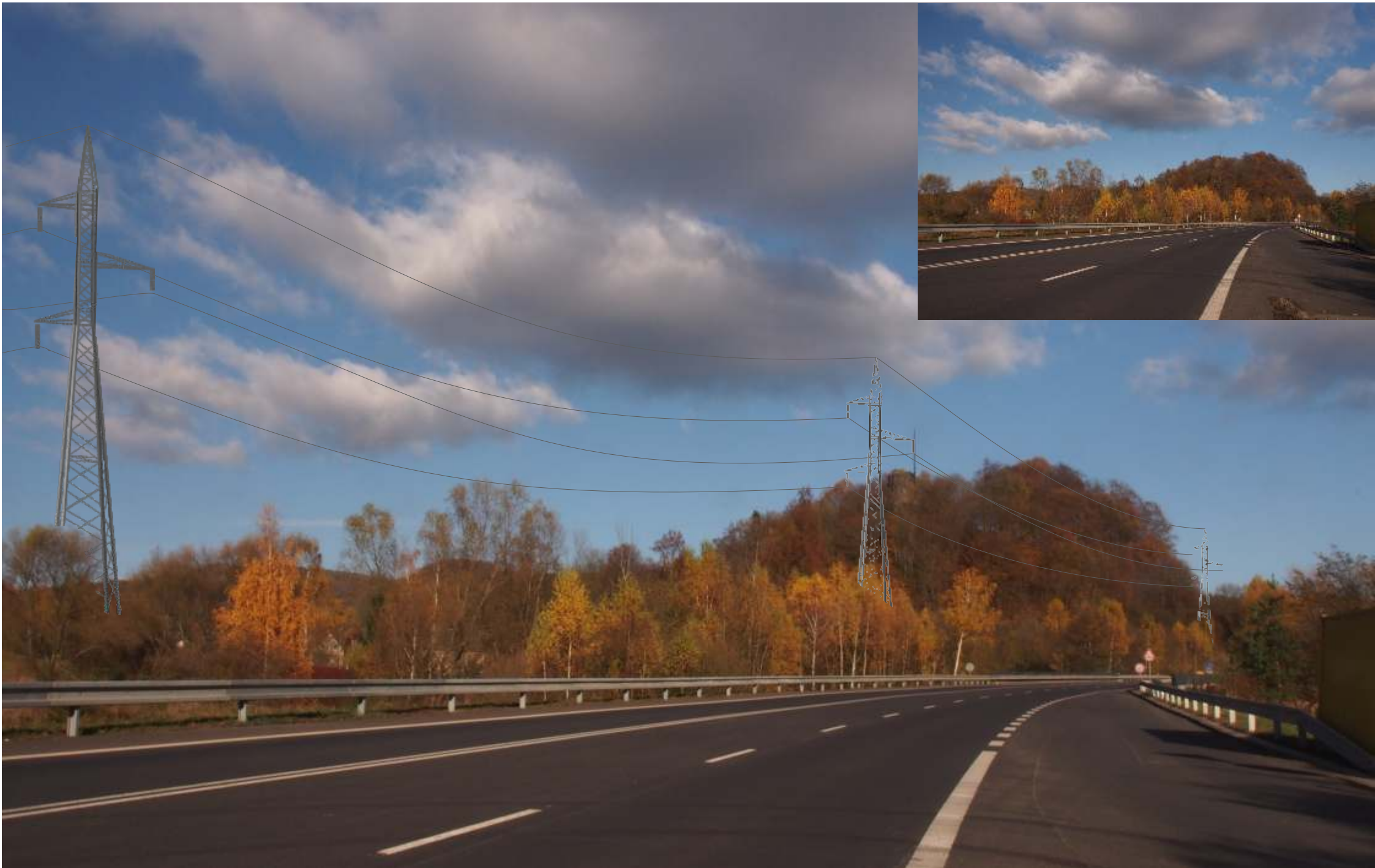
Skalka - vedení 110 kV souběžně se silnicí I/9 Nový Bor - Svor. Stožáry jsou kryty pouze nízkým podrostem (do 3m). Pohledově působí jako výrazná negativní dominanta. Příhradová konstrukce stožáru typu „Soudek” působí lehčeji díky své průhlednosti.
