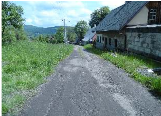
oprava MK Pražská ul.
