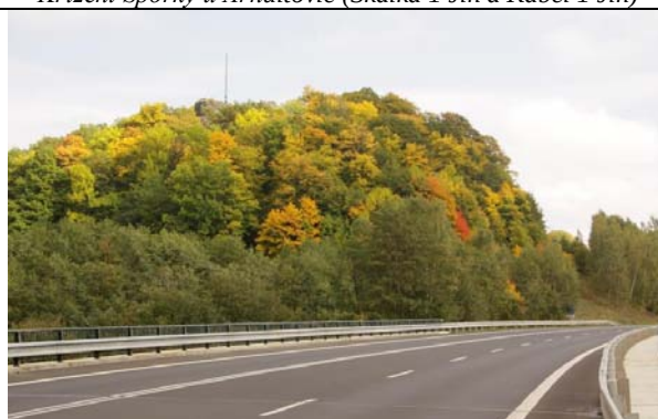
Celkový pohled na koridor pro obě jižní varianty na jižním svahu vrchu Skalka
