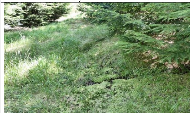
Paludifikace kolem plynovodu v místě přechodu kabel-nadzemní trasa
