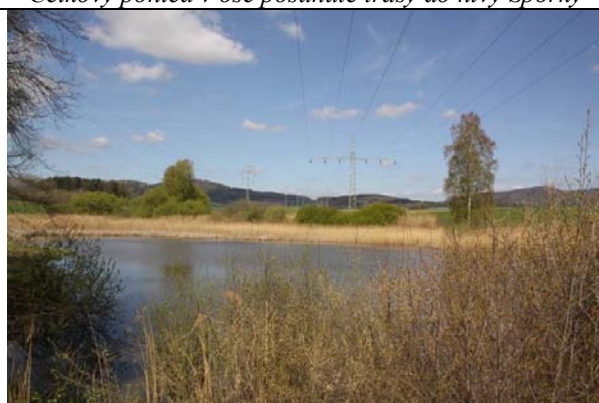
Křížení v prostoru rybníka Souška, rekonstrukce
