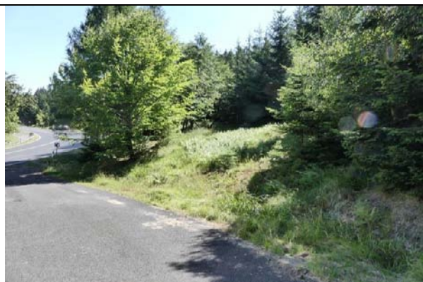
Místo přechodu z kabelu do nadzemní trasy J od osady Lesné
