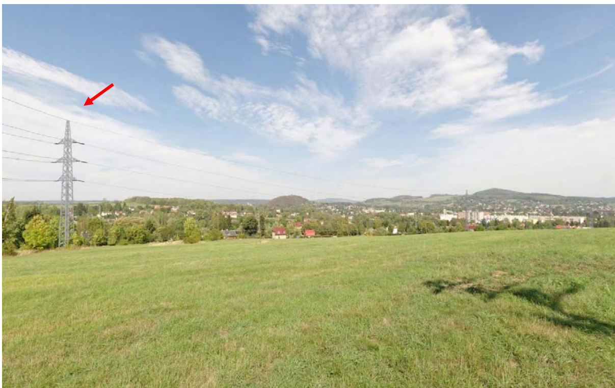
Pohled na poslední lomový stožár R42 před úsekem vedoucím do TR Varnsdorf
