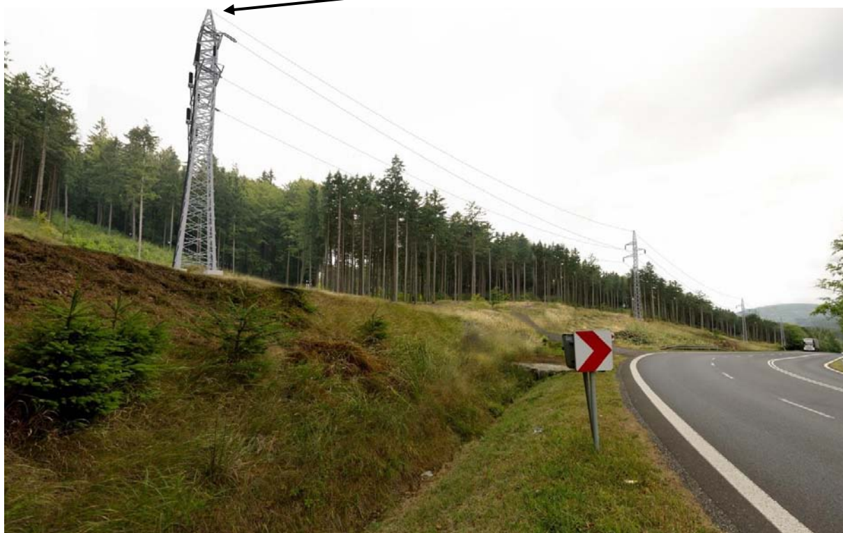
Přechodový stožár za Stožeckým sedlem
