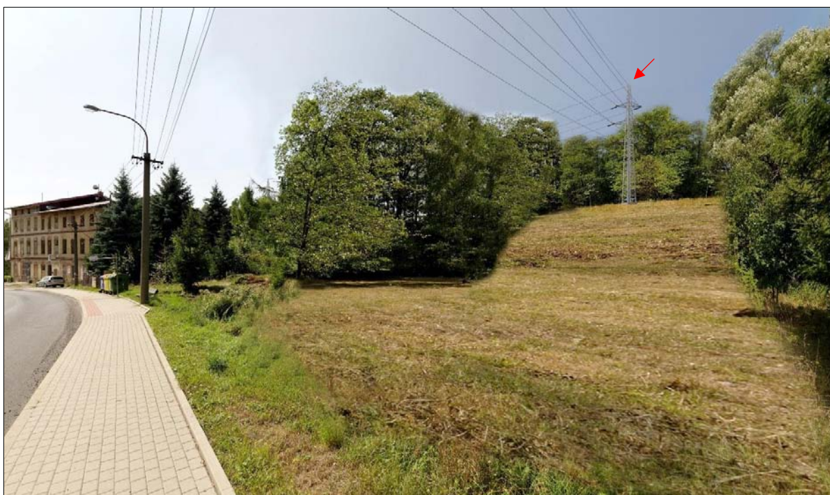
Alternativně půjde-li o nadzemní trasu (nadměnní varianta č. 2 Střed), stejné místo se stožárem nadzemního vedení (R51)
