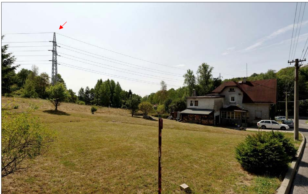
Pohled z ulice lesní čtvrť na přechod trasy loukou za ním. V popředí č.p. 472, dům č.p. 62 v ul. Gen. Svobody, přes jehož pozemek trasa přechází, je skryt za ním. Viditelný lomový stožár č. R55
