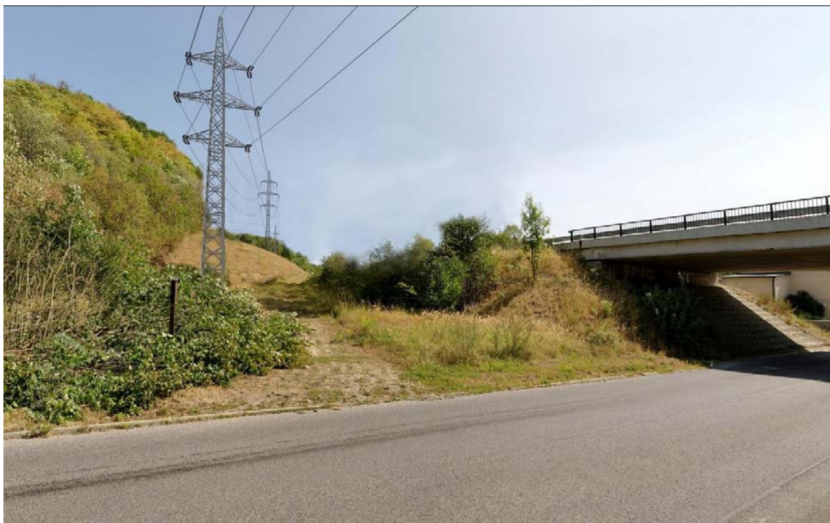
Pohled na trasu vstupující do prostoru jižně od Skalky v souběhu se silnicí I. třídy. V popředí lomový stožár R7.
