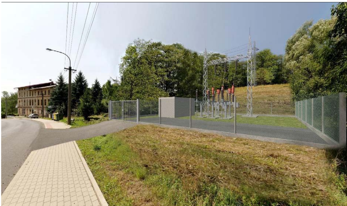
Přechodová spínací stanice začátek kabelové trasy Střed, ul. Gen. Svobody
