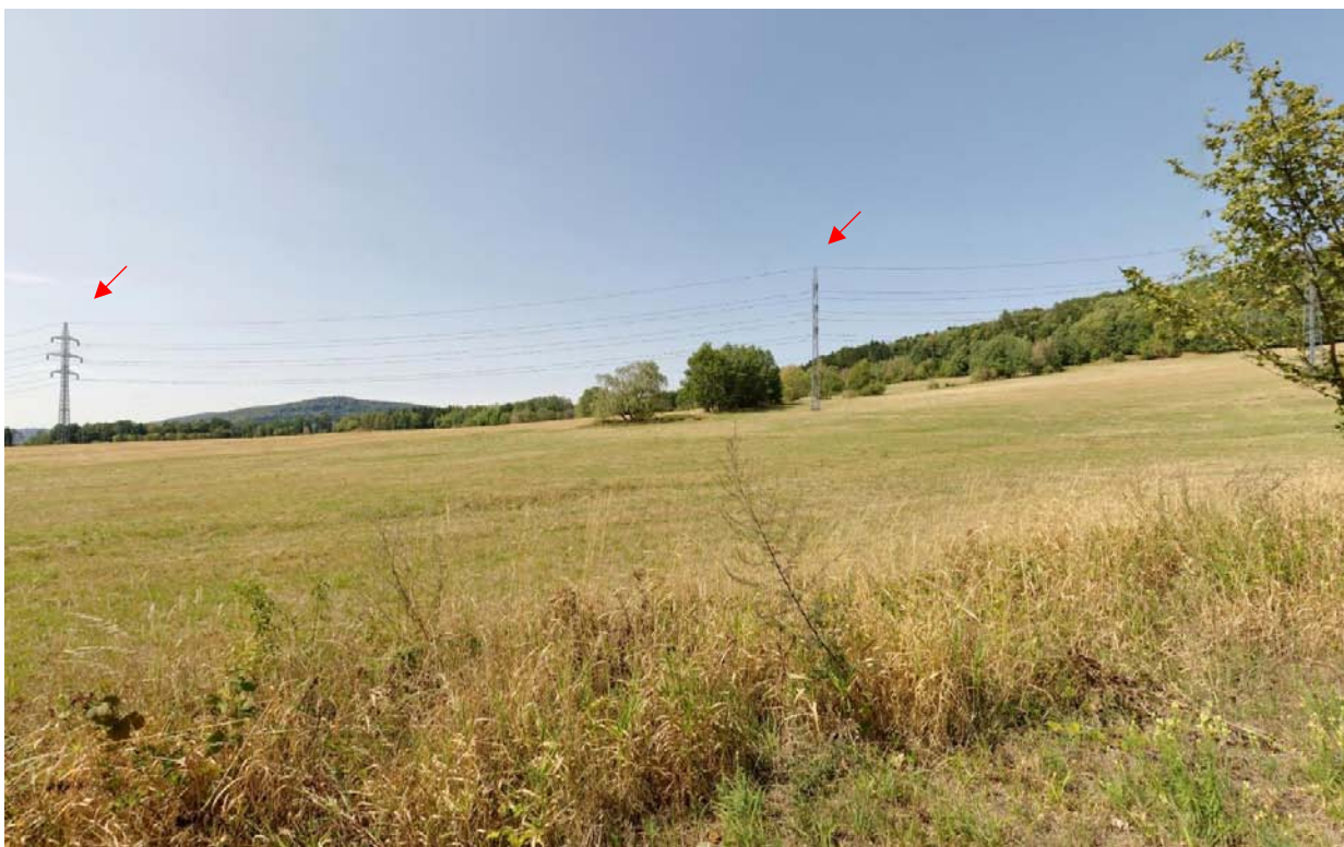
Začátek trasy ve stávající trase VN 35 kV, viditelné 2 nosné stožáry za lomovým R5. Společný úsek pro variantu č. 2 a č. 3
