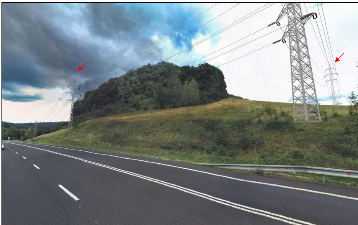
Pohled ze silnice I/9 na lomový stožár R8 a předchozí a následující nosný stožár J a V od Skalky
