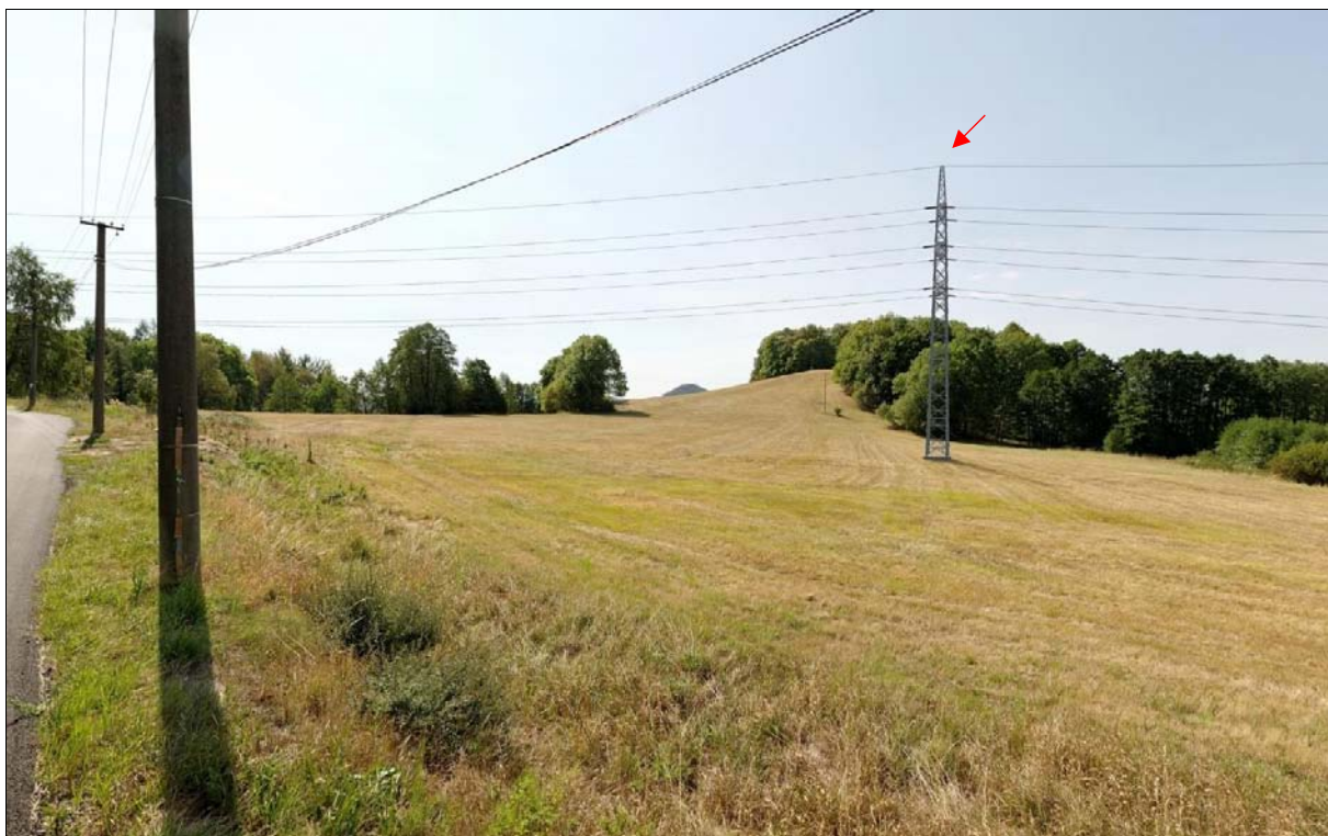
Pohled na nejvíce viditelný lomový stožár R66 na louce za Skalkou z ul. Havlíčkova
