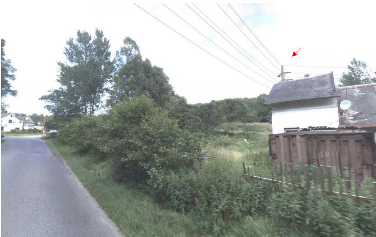
Pohled z ulice Gen. Svobody na přechod trasy přes pozemek objektu č.p. 62. Viditelný je lomový stožár R55.
