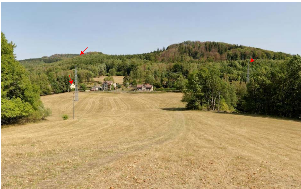
Pohled na nejvíce viditelný stožár R66 na louce za Skalkou od Skalky. Na obrázku jsou patrné stožáry VN 35 kV, které budou odstraněny a stožár v místě vstupu do lesního porostu
