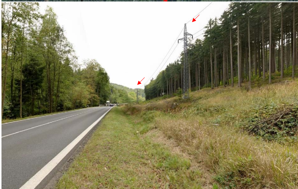
Nadzemní trasa podél silnice, pohled od Lesného. Patrný nosný stožár mezi R27 a R28.
