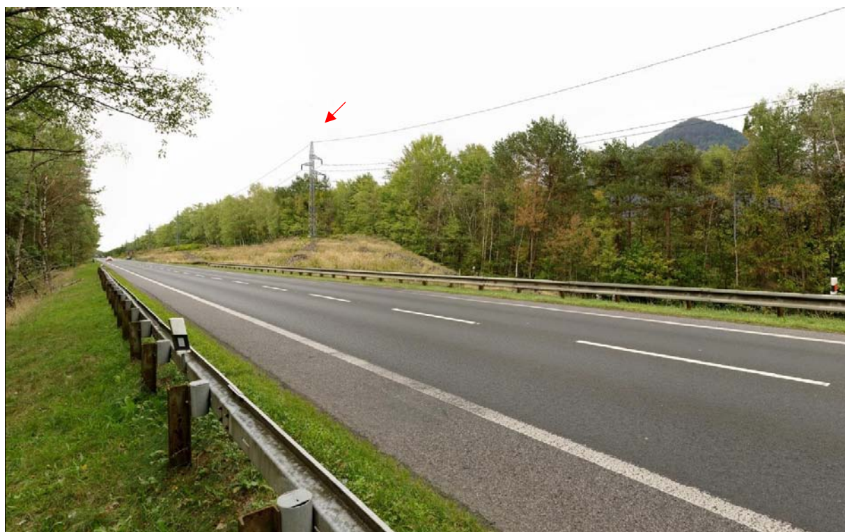
Trasa mezi Novým Borem a Svorem před křížením silnice I. třídy, viditelný poslední nosný stožár před R16.
