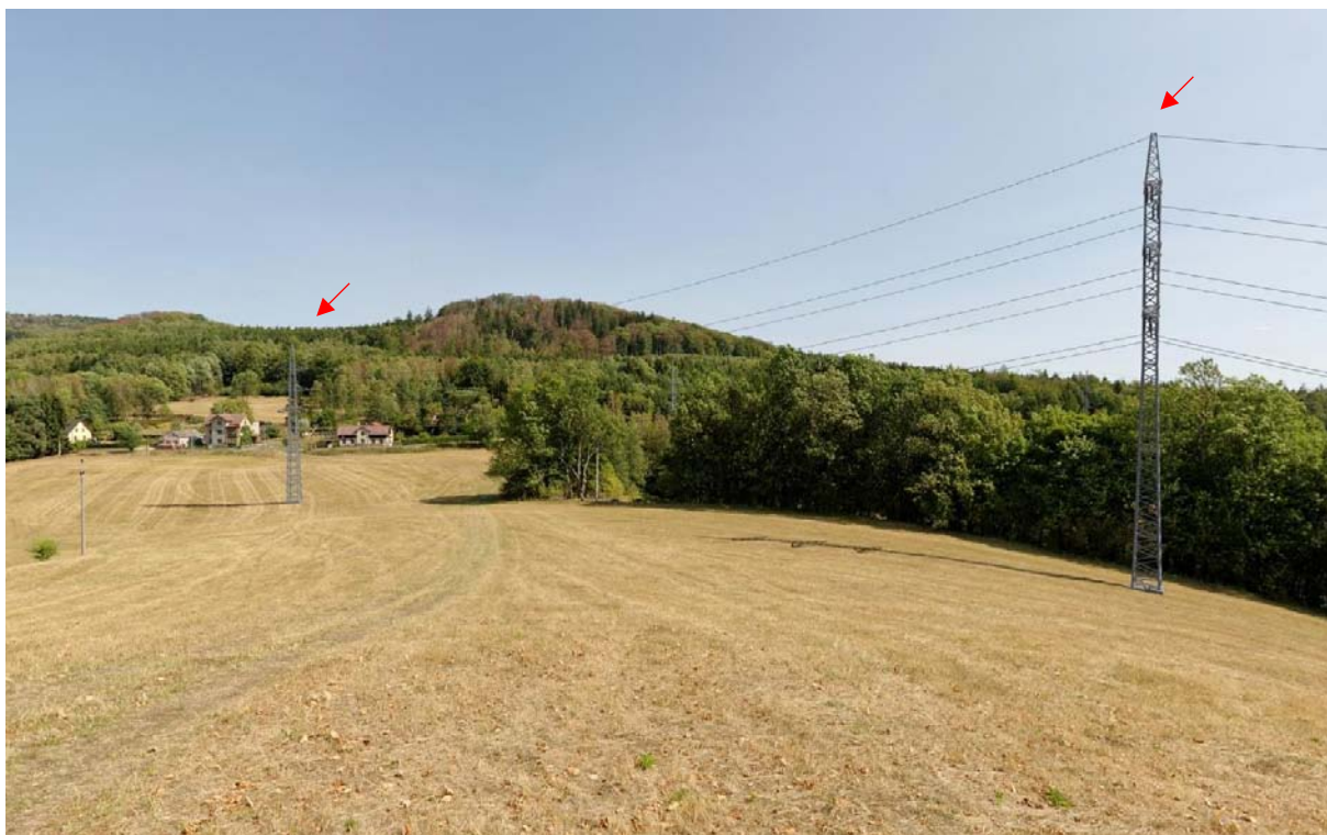
Pohled z louky za Skalkou na průchod trasy severně od Skalky, patrný lomový stožár R9 a předchozí nosný stožár
