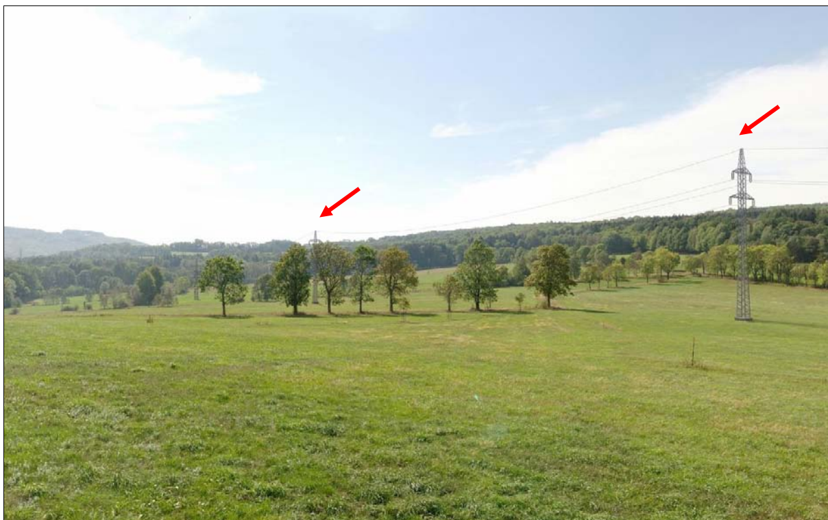
Louky před Varnsdorfem, zde v již trase stávajícího vedení VN 35 kV. Pohled od lomu jižním směrem na poslední nosný stožár před R41b
