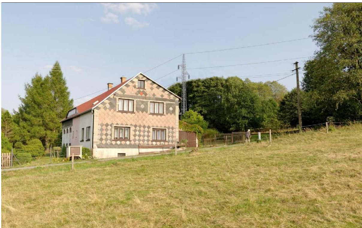
Dům č.p. 368 v Dolním Podluží trasa míjí zezadu. Jde o největší přiblížení trasy k obytnému objektu v Dolním Podluží
