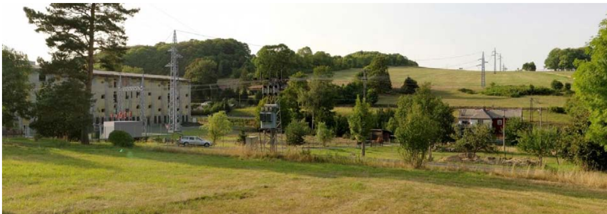
Na stejném místě přechodová spínací stanice
