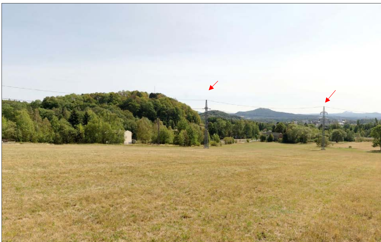
Stejný úsek trasy ve stávající trase VN 35 kV, pohled od západu na rohový stožár R50 a předchozí nosný stožár. Společný úsek pro variantu č. 2 a č. 3
