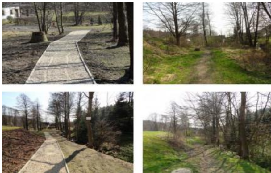
Obrázek 11 - Rekonstrukce chodníčku pod tenisovými kurty
