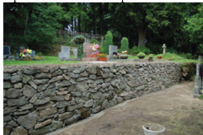
Srpen 2011 – částečná oprava
