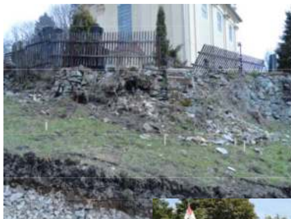
detail zdi r. jaro 2012
